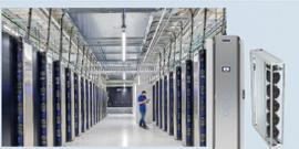
Gestion optimisée des flux d'air, couloirs froids et échangeurs de chaleur à l'arrière des portes
