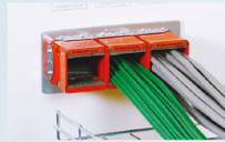
Protection optimale contre la propagation du feu, quel que soit le facteur de charge des câbles
